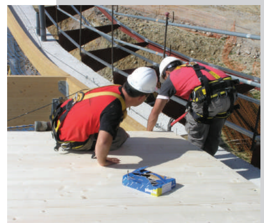
Pose d'une toiture en Sapisol®
