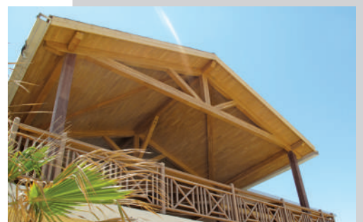
Portée et sous-face finie en une seule opération
