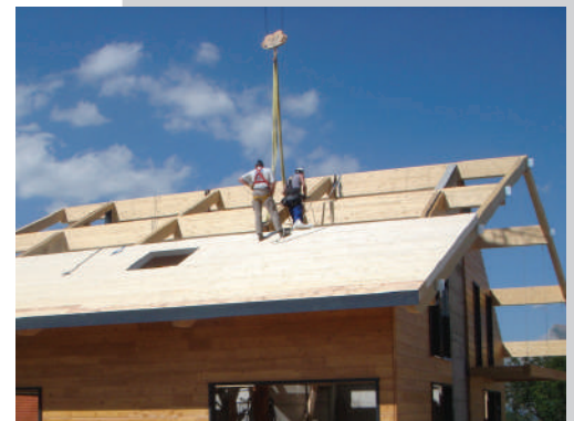
Pose d'une toiture en Sapisol®
