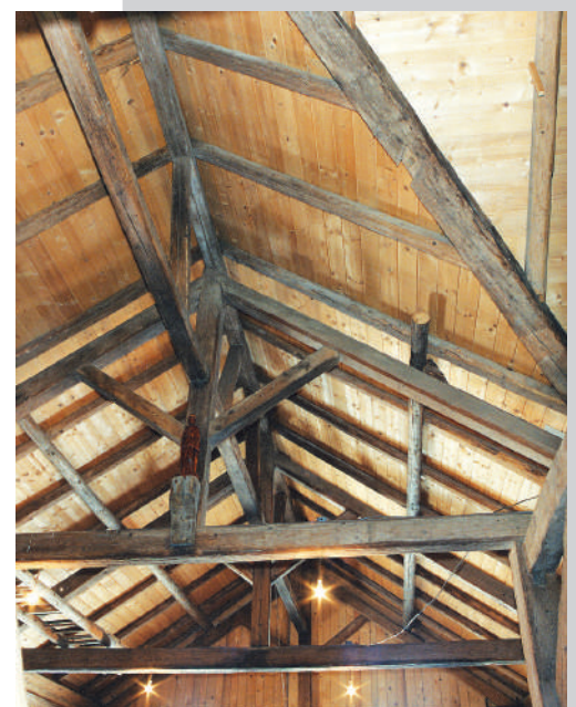
Pose en rénovation
