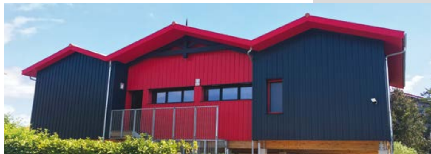
Planches brossées 25 x 210 mm et couvre-joints de section 21 x 68 mm, couleur gris anthracite et rouge framboise
