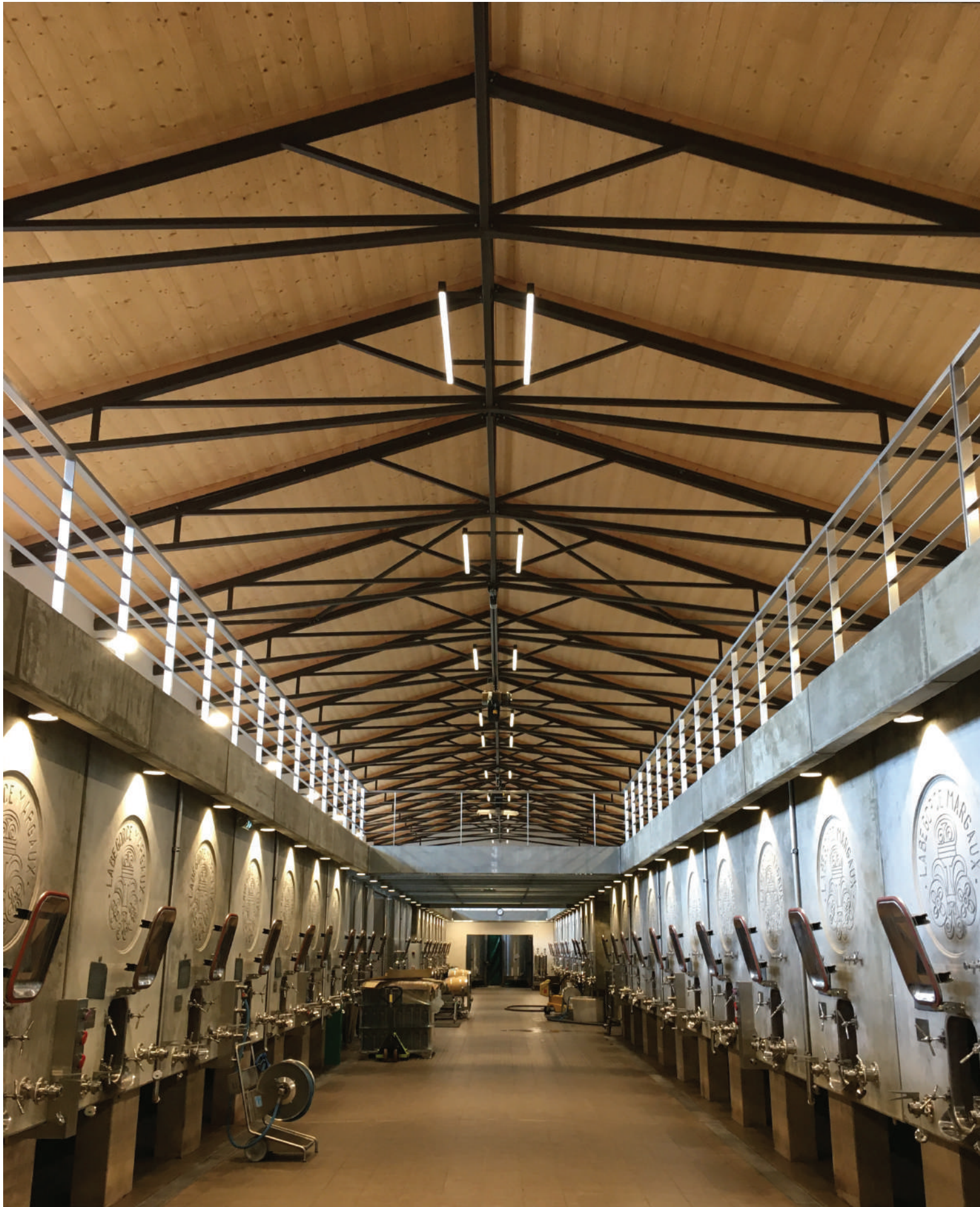
Sapiso® avec face épicea vieux bois sur charpente métallique
