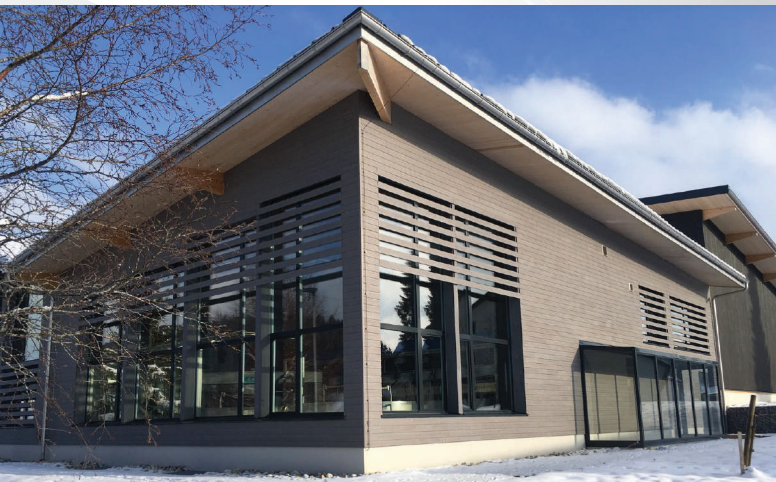
Structure LC épiciéa, Sapisol® épiciéa et bardage Funlam® épiciéa, profil 21, saturateur gris clair et gris foncé
