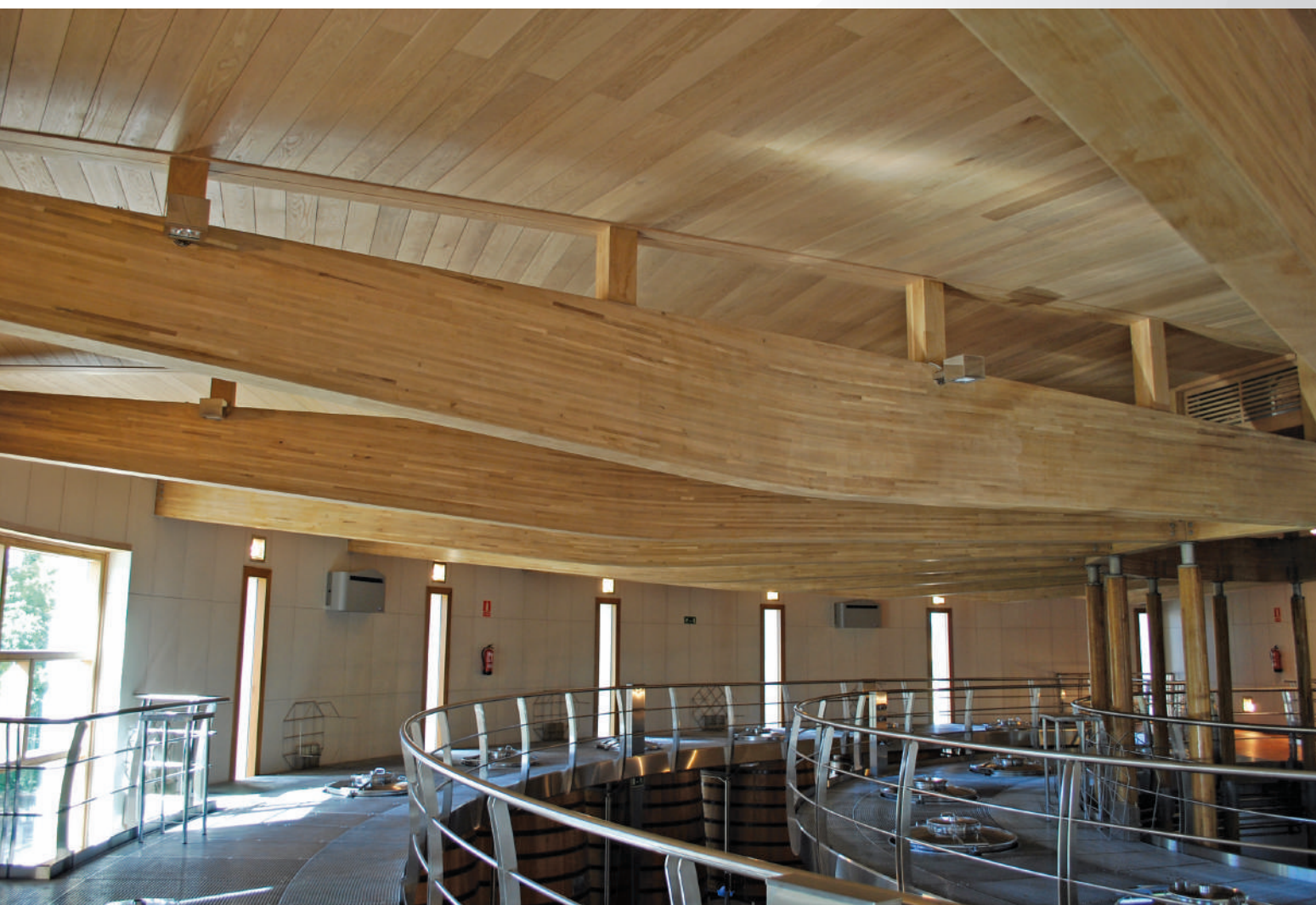
Charpente LC droit et cylindrique chêne
