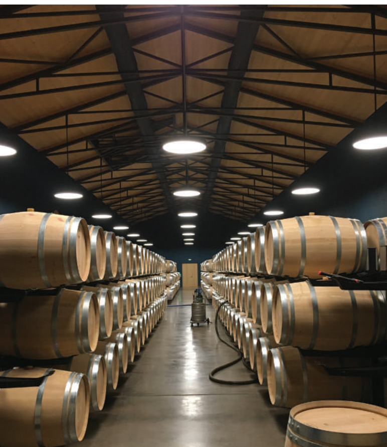
Sapiso® avec face épicea vieux bois sur charpente métallique
